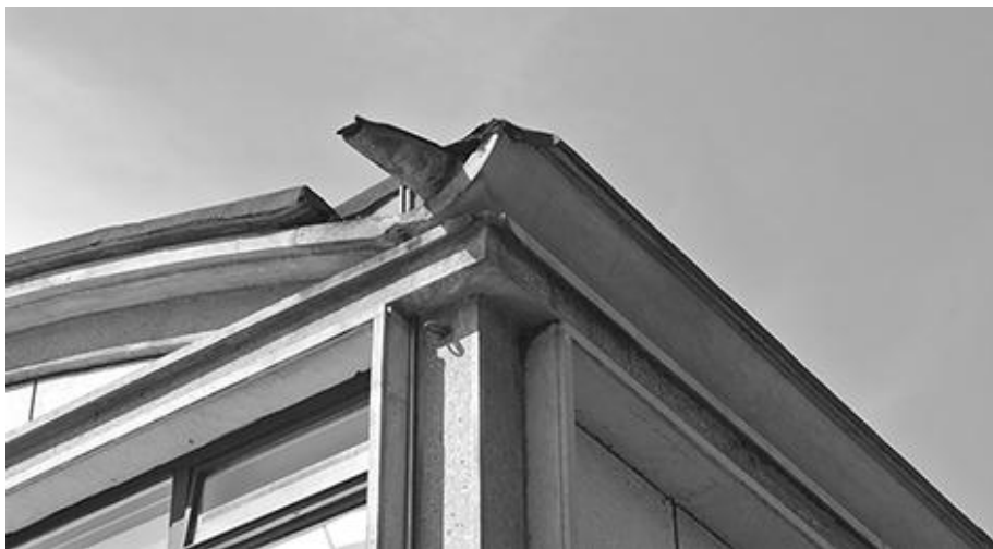
fig. 15: dettaglio del trattamento dei diversi elementi di facciata. (Foto dell'autore, 2017)
