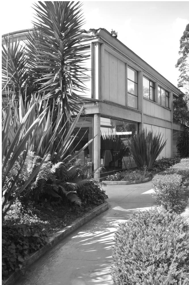
fig. 1: Casa Shaio allo stato attuale, sede del Club Colombo-Libanese. Fronte sud-est. (Foto dell'autore, 2017)
