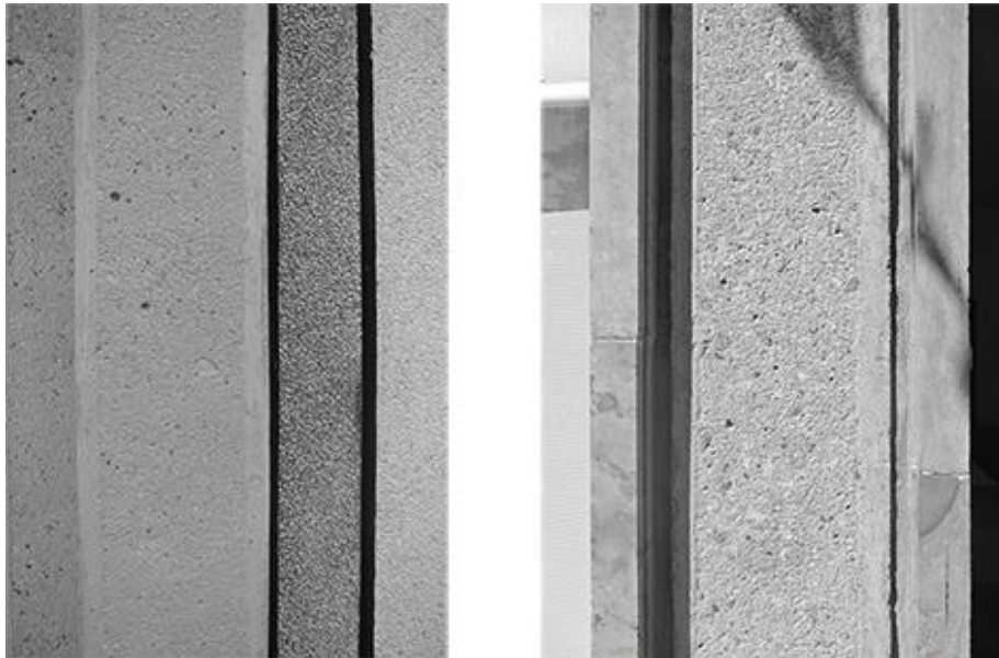
fig. 14: dettaglio del trattamento dei settori di tamponamento in cemento. (Foto dell'autore, 2017)
